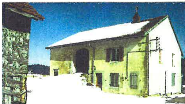
LES PIARDS : la levée de grange est sous la gouttière.
