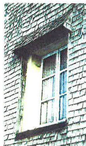
Bardage Sud Ouest en tavaillons.
